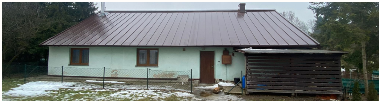
Obr. Nová střešní krytina na myslivecké chatě
