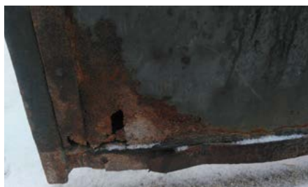
Poškozená hlavní zámecká vrata před opravou a po opravě
