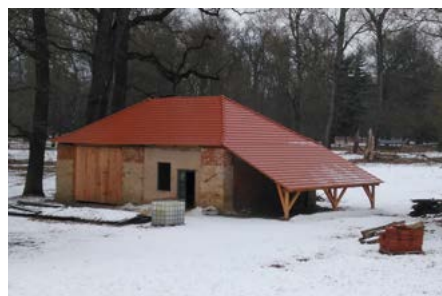
Seník po rekonstrukci
