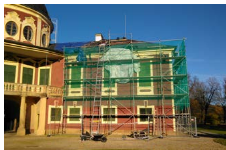
Výměna střešní krytiny
