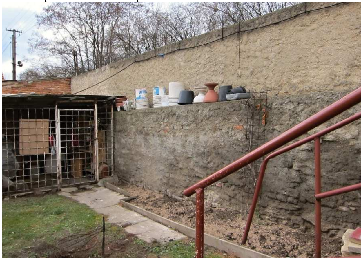
Foto č.9 - opěrná stěna na hranicích pozemku č.41/2
