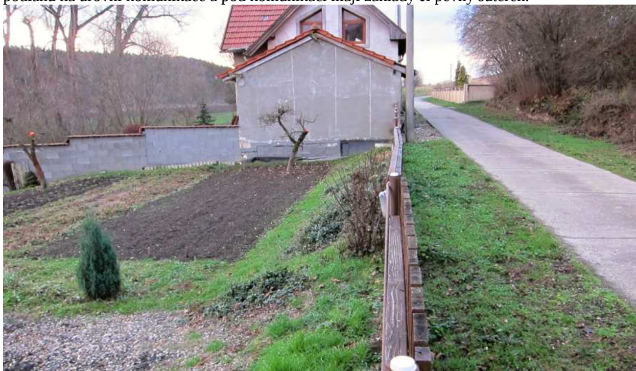
Foto č.10 - vzdálený již bezpečný konec komunikace - zde je již vidět bezpečné svahování menšího terénního rozdílu a novější stavby jež mají podlahu na úrovni komunikace a pod komunikací mají základy či pevný suterén.
