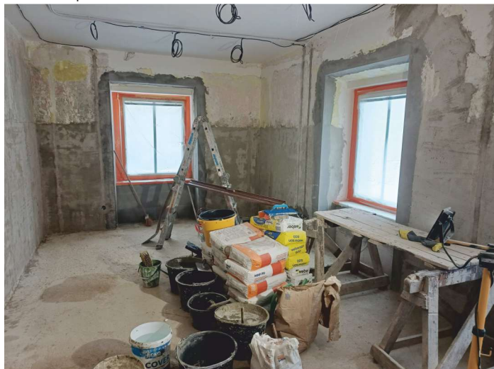
Stavební práce v nové ordinaci ve Zdravotním středisku Žulová
