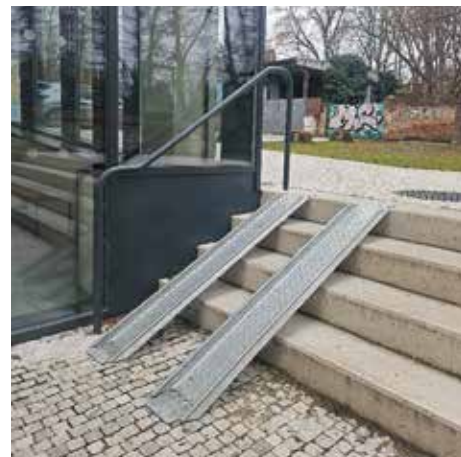
Hala Josefa Kaluhy - nechali jsme vyrobit nové nájezdové kolejnice k venkovnímu schodišti, které usnadní přístup do nové sportovní haly Josefa Kaluhy.
