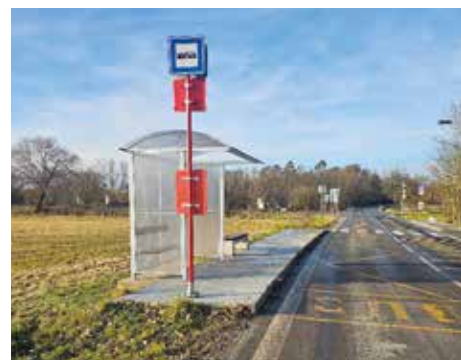
Nové zastávky - Nově byly instalovány přístřešky u autobusových zastávek pro cestující v ulicích Boleslavská a Mělnická.
