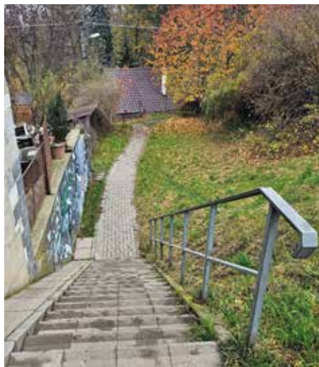
Opravené schůdky - v oblasti Dělnických domků byly vyměněny schodnice na cestě směrem k Labi.
