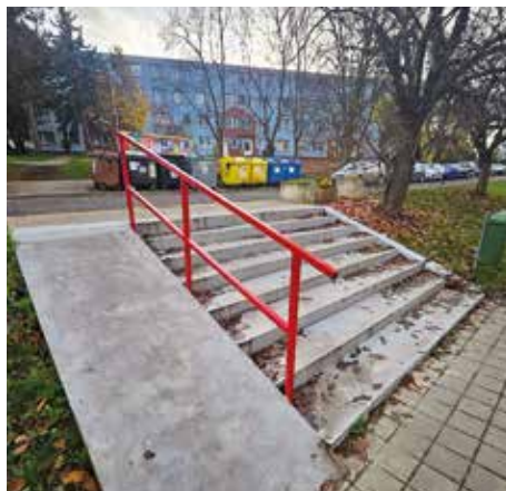
Schody v Jasanové - Technické služby opravily zábradlí a betonové schody v Jasanové ulici v brandýském sídlišti.
