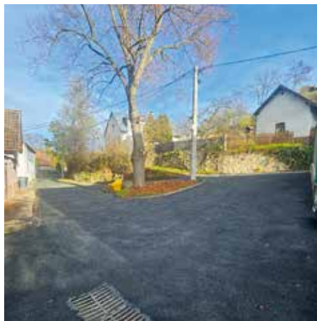
Popovice, část Řinčov – za téměř půl milionu korun byla upravena a odvodněna místní komunikace a realizována nová parkovací místa, což výrazně zlepšilo kvalitu bydlení v dané lokalitě.
