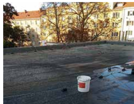
ZŠ Palachova - Finančně jsme pokryli rekonstrukci střechy nad školní jídelnou v ZŠ Palachova, do které zatékalo. Technicky vše zajistil pan školník Cestr, za což mu děkujeme.
